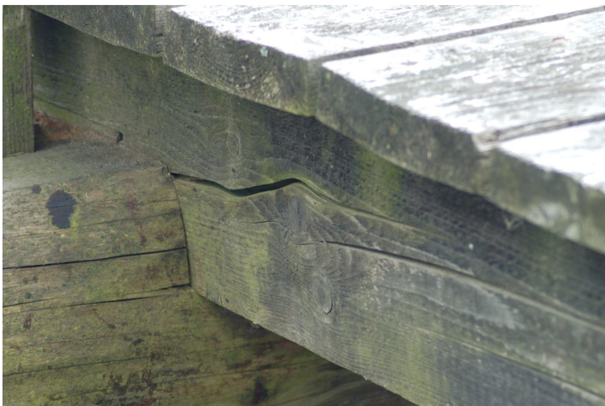
Bardzo głębokie zaciosy osłabiają przekrój nośny w obu łączonych elementach.
