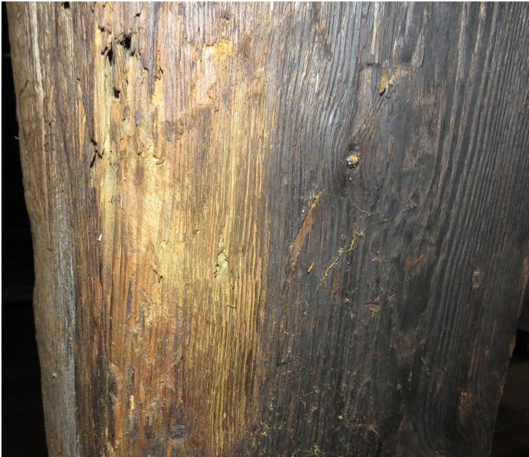
Widok drewna oczyszczonego szczotką drewnianą
