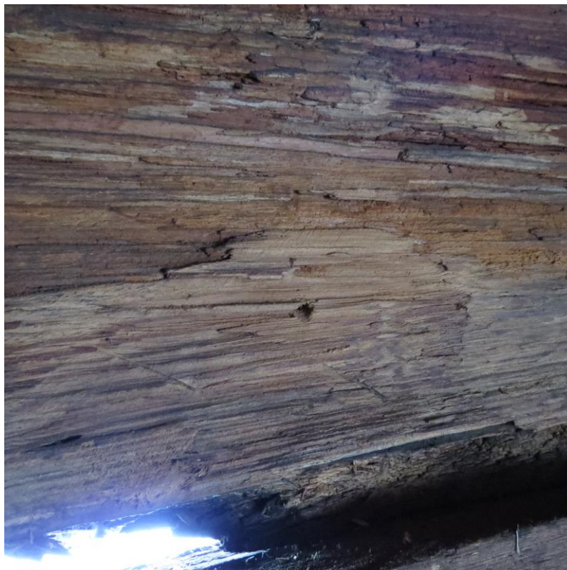
Miejsce dokonania nawiertu w ścianie
