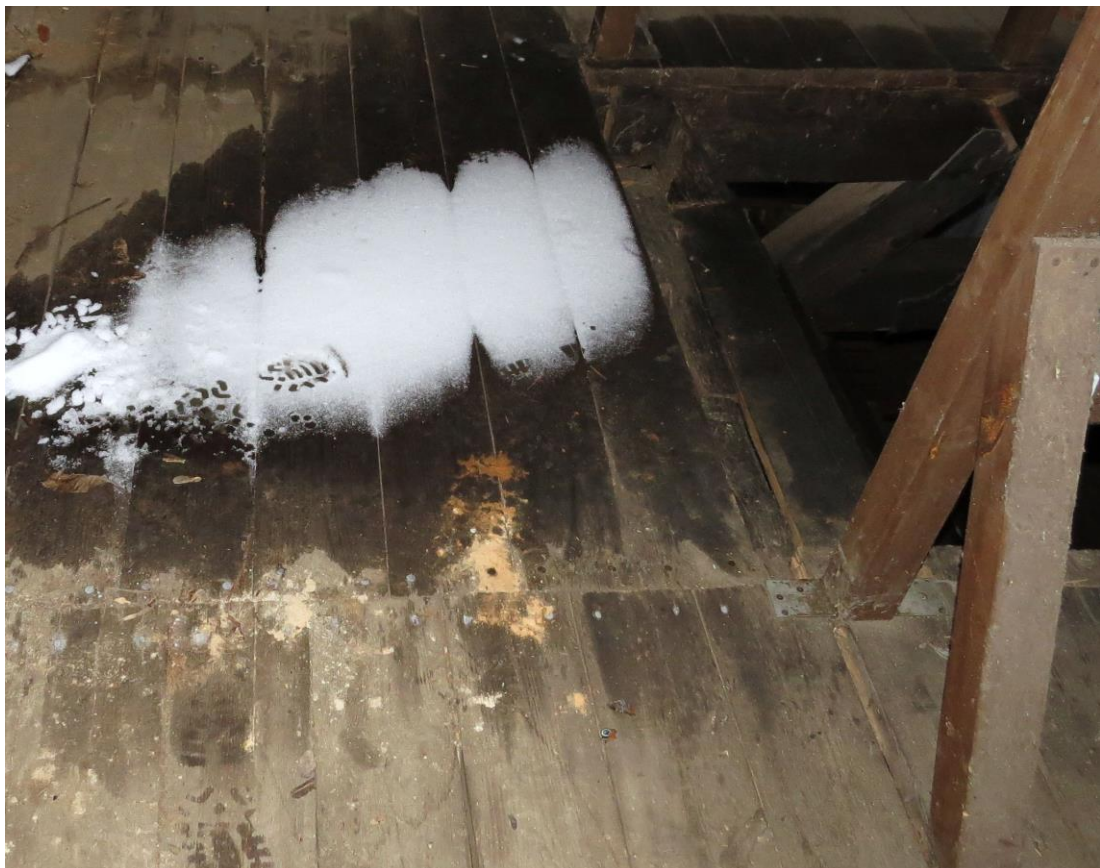
Miejsce dokonania nawiertu w podłodze na poddaszu
